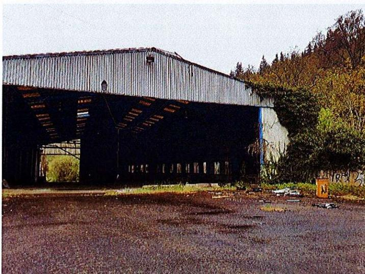
Figure 21. Lierre grimpant se développant sur un hangar
